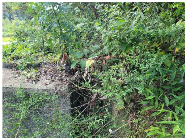
주변영향인자(성토부, 상부 본선) 상태현황
