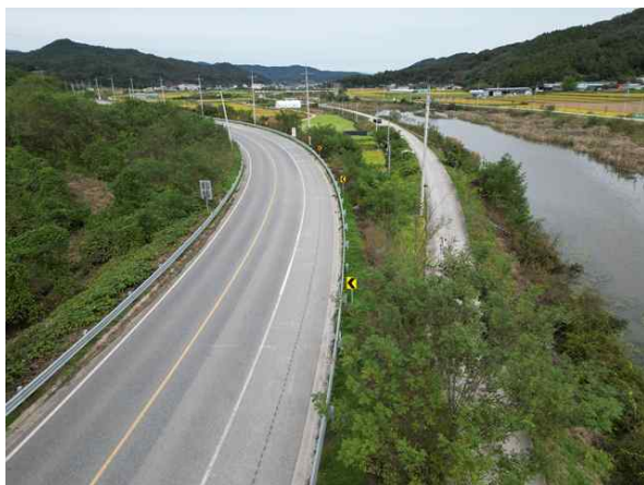
주변영향인자(성토부, 상부 본선) 상태현황
